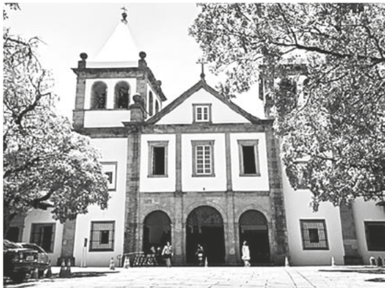
Mosteiro de São Bento (RJ)
